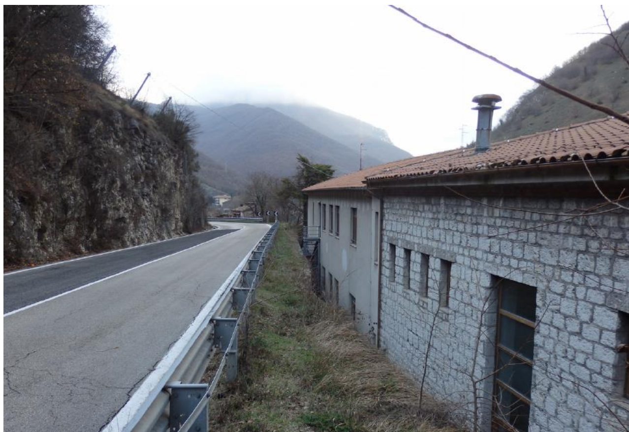
Spazi esterni retro edificio
