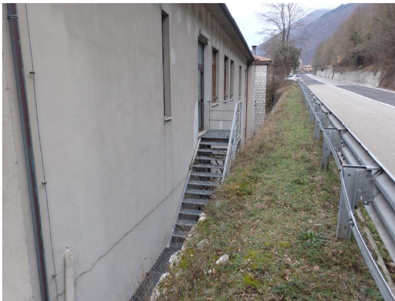
Spazi esterni retro edificio
