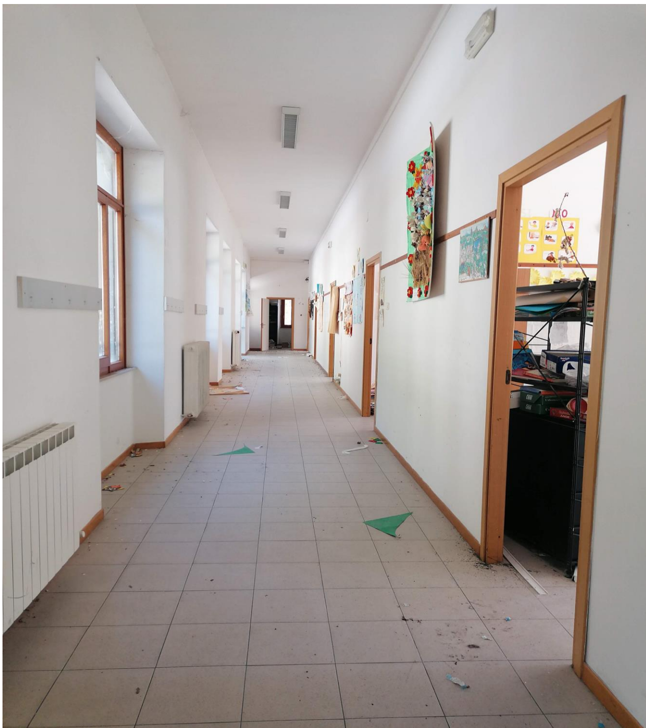
Corridoio nord-est _ Piano Primo
